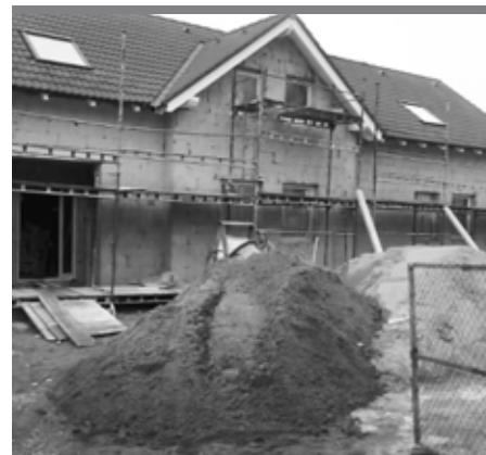
VÝSTAVBA NOVÁHO DETSKÉHO DOMOVA FOTO: JÁN KOKARDA
