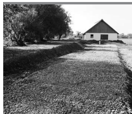
VÝSTAVBA ČISTIČKY ODPADOVÝCH VÔD FOTO: JÁN KOKARDA
